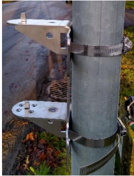
Abbildung 10: Halterung und Schellen in der Seitenansicht
