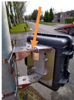
Abbildung 21: Klemmschraube im -45°-Winkel mit Vorhängeschloss
