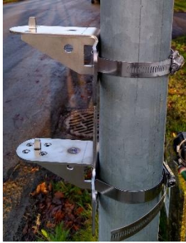
Figure 10 : support et colliers de profil
