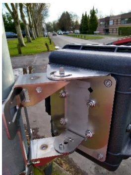
Figure 20 : vis d'orientation à -45°
