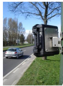
Figuur 9: achterzijde van de geplaatste radar
