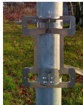
Figuur 11: montagestuk en beugels, voorzicht
