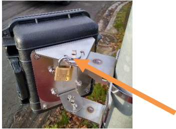
Figuur 23: opening voor slot
