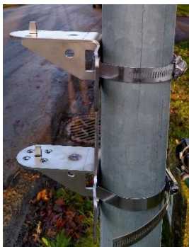
Figuur 10: montagestuk en beugels, zijzicht
