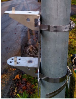
Figure 10 : support et colliers de profil
