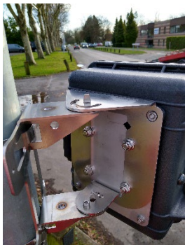
Figure 20 : vis d'orientation à -45°
