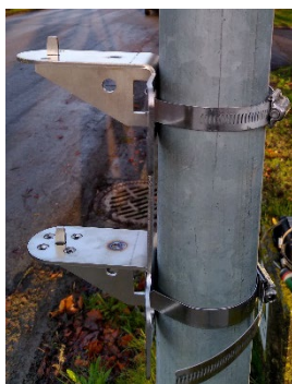
Figuur 10: montagestuk en beugels, zijzicht
