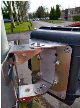
Figuur 20: oriëntatieschroef voor -45°
